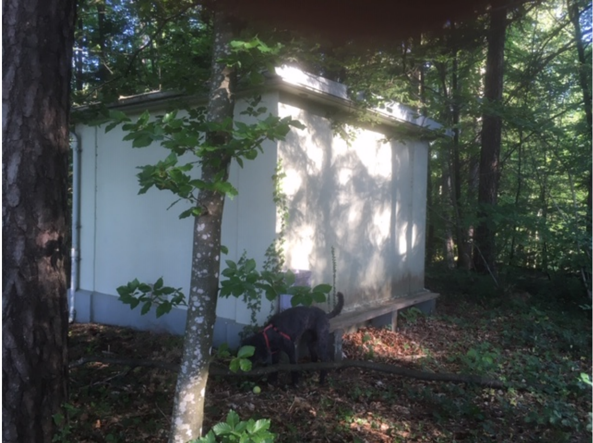
Abb. 17.1. Das älteste Trinkwasser-Reservoir Waldegg in Wetzikon, erstellt im Jahre 1889, in Betrieb bis 2012
