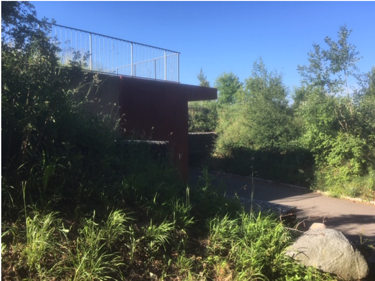
Abb.17.2. Das im Jahre 2012 neu erstellte Trinkwasser-Reservoir Bühlholz
